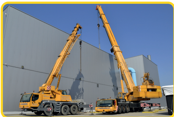
Der Einsatz der Kräne für den Austausch des Beckens
